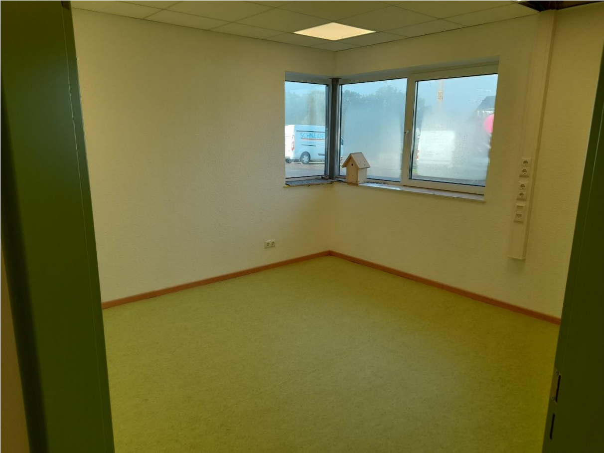
Büro und Personalraum ist bereit...
